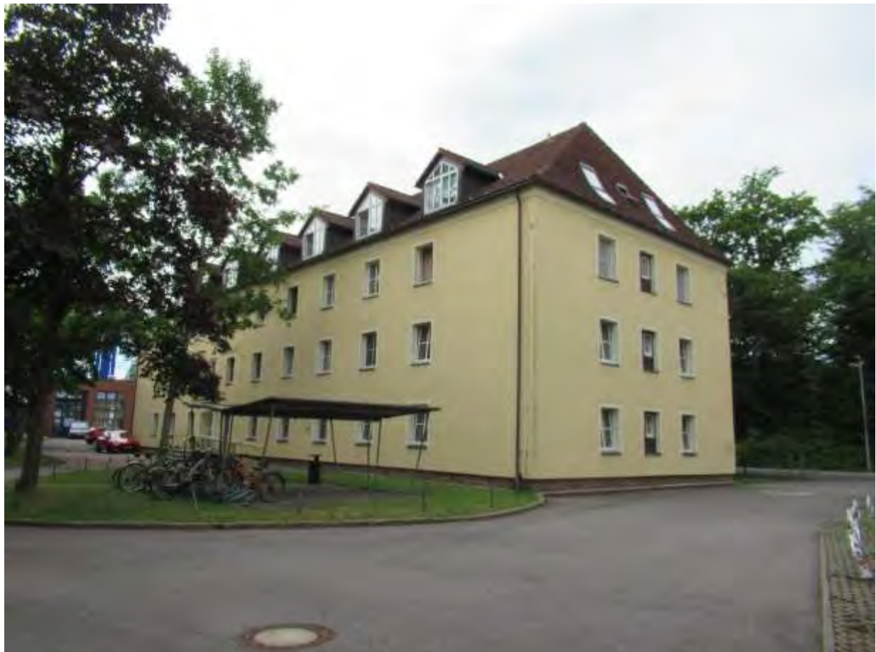
Ecke Ansicht Nord-Ost/Nord-West
