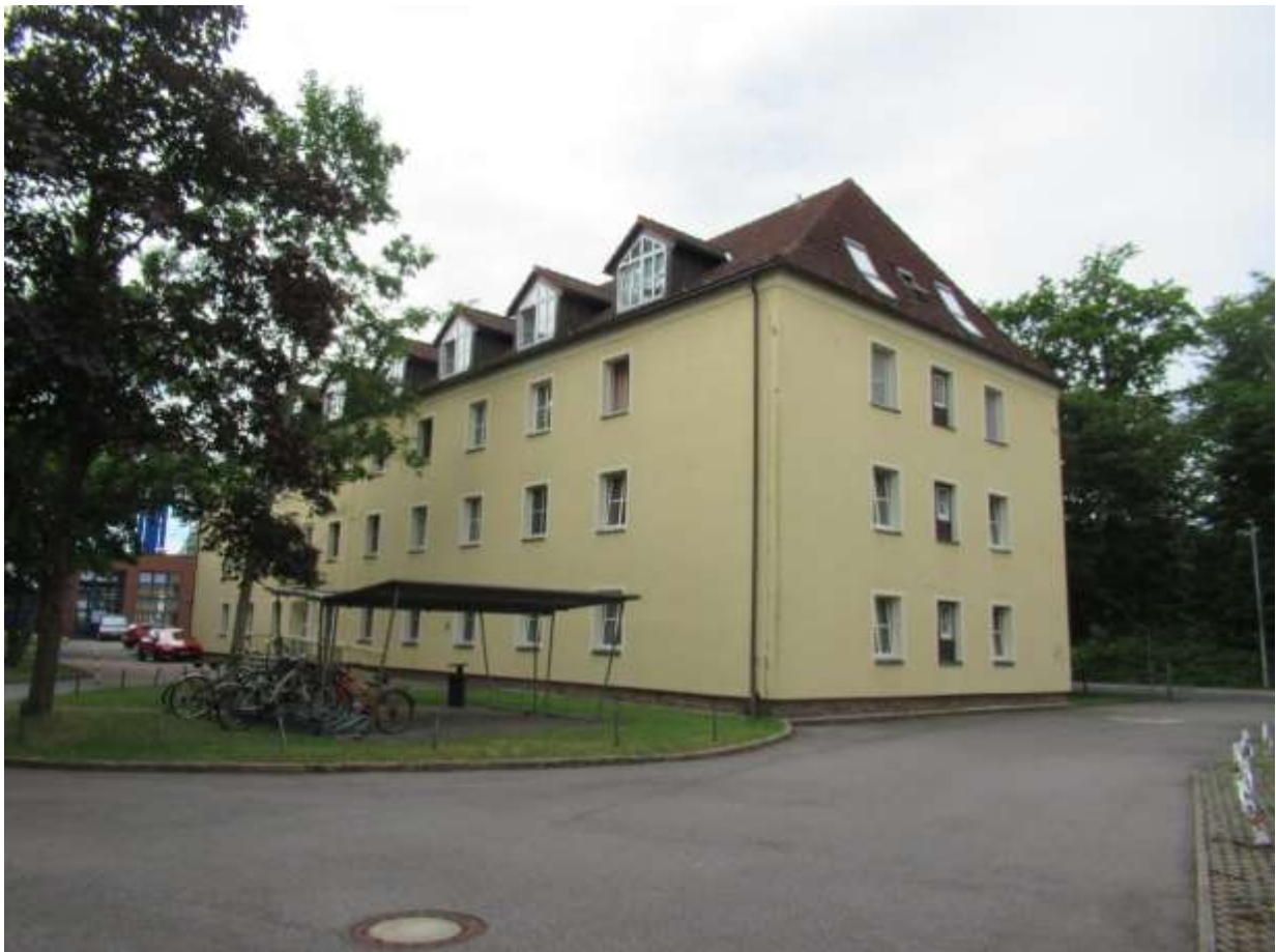
Ecke Ansicht Nord-Ost/Nord-West
