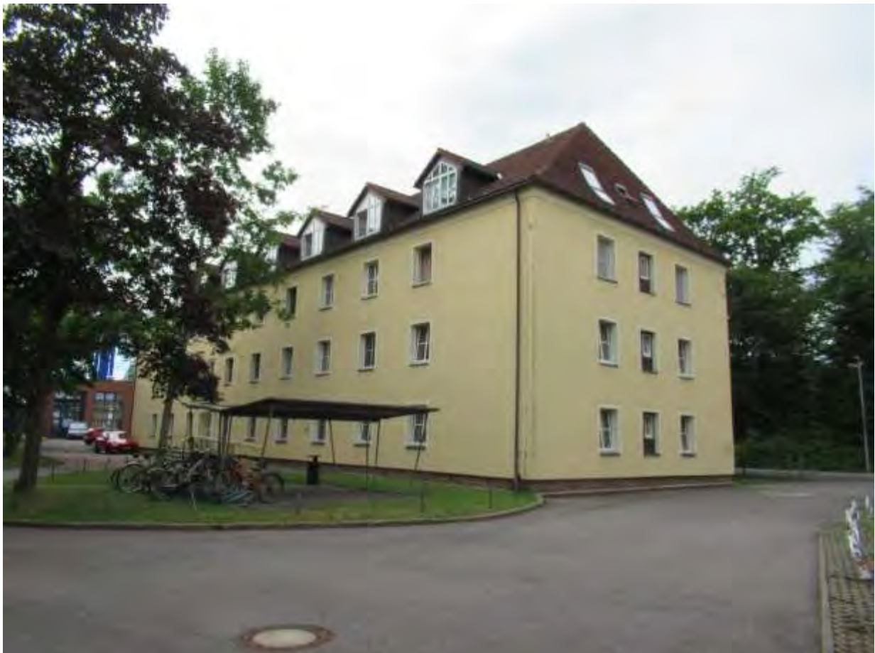
Ecke Ansicht Nord-Ost/Nord-West
