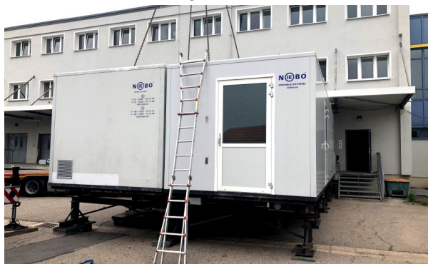
Bild 6 - Anlieferung der Kochcontainer
