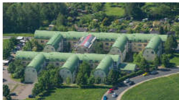
Bild 3: Stück für Stück werden die Dächer des Bereiches Prof.-Holzt-Straße erneuert, um die Baumängel endlich grundsätzlich zu beseitigen.
