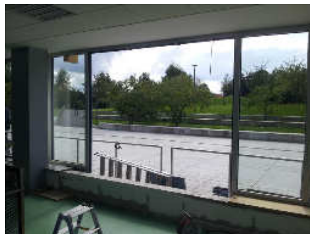
Bild 2: In dieses Loch der Freiburger Mensa wurde eine der neuen Fluchttüren eingebaut.
